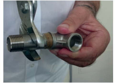
Fitting anziehen mit geeignetem Werkzeug Vissent avec l'outil adéquat Vite con un attrezzo adatto
